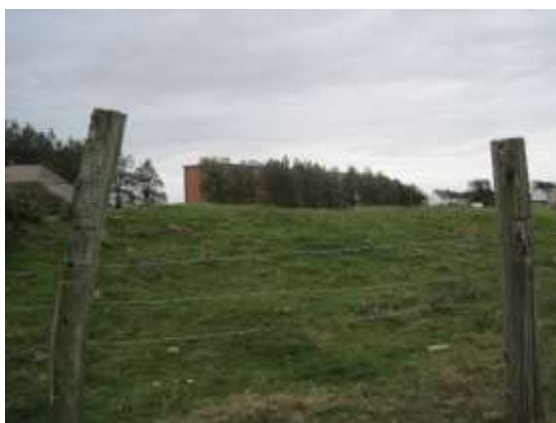
Vue de la digue de 1925 qui est un point de rupture avec derrière la résidence précitée.
