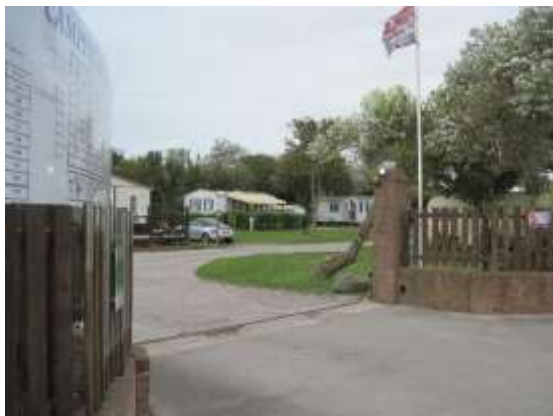
Vue de l'entrée du camping de la Plage qui est dans la bande de précaution
