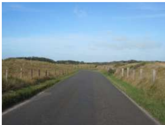
Franchissement de la digue Taff par la route reliant Grand-Fort-Philippe au quartier des Écardines de Oye-Plage.
