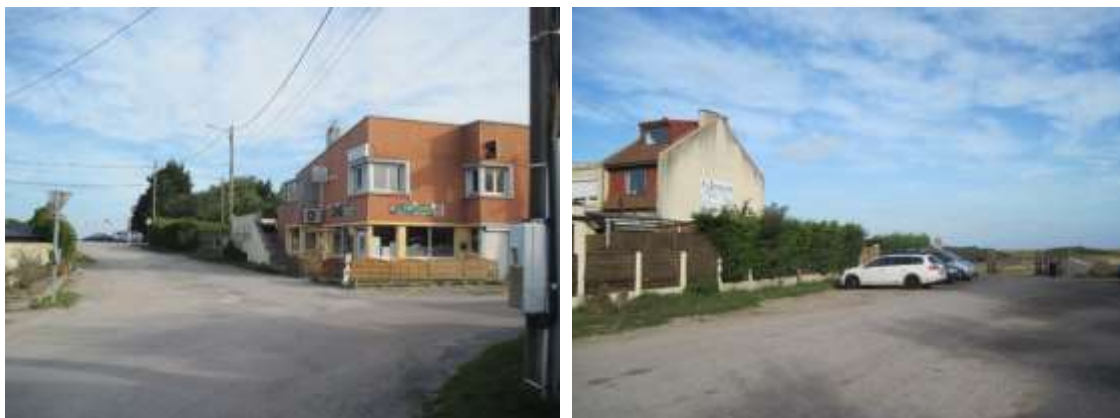
Vues générales du lieu-dit « l'Abri Côtier » et du parking desservant la réserve naturelle du Platier d'Oye qui sont en zone rouge .
